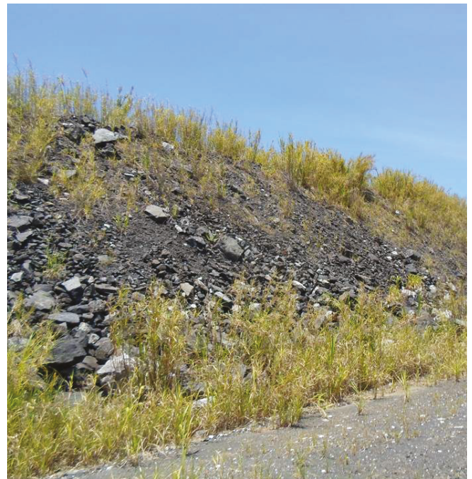
Figura 3 – Feição geral de talude da pilha de estéril.
