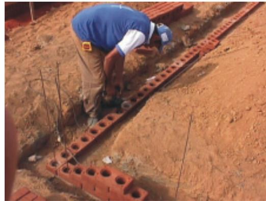
Ilustração 3 – Construção do protótipo de casa em tijolo de solo-cimento
