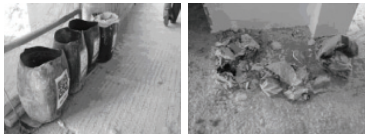
Figura 5 e 6 – Problemas Comuns Detectados nos Canteiros de Obras.
