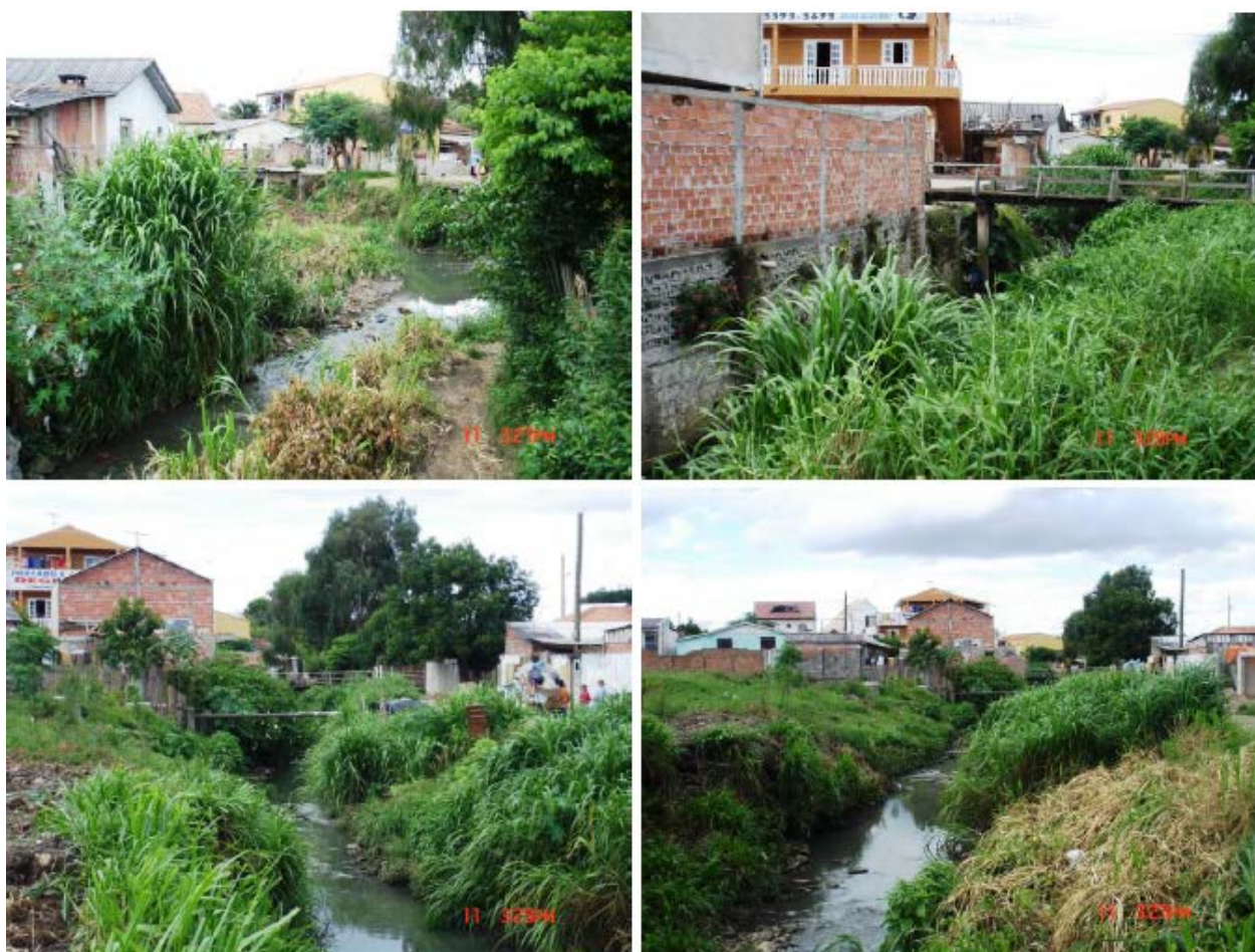
Figura 1 – Ocupações irregulares nas margens do Ribeirão dos Müller, Comunidade Jardim Gabineto (CJG), Curitiba, PR, Brasil.
