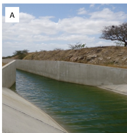
Figura 3 – (A) Visão da estrutura trapezoidal e retangular do canal; (B) visão geral de um trecho; (C) trecho do canal na rodovia BR-432 com operação de caminhão pipa para abastecimento público.
